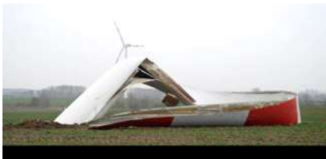
Foto: Das zerstörte Rotorblatt stürzte 100 Meter in die Tiefe. Es soll sechs bis acht Tonnen schwer sein. Foto: Schweriner Volkszeitung, Michael Schmidt
