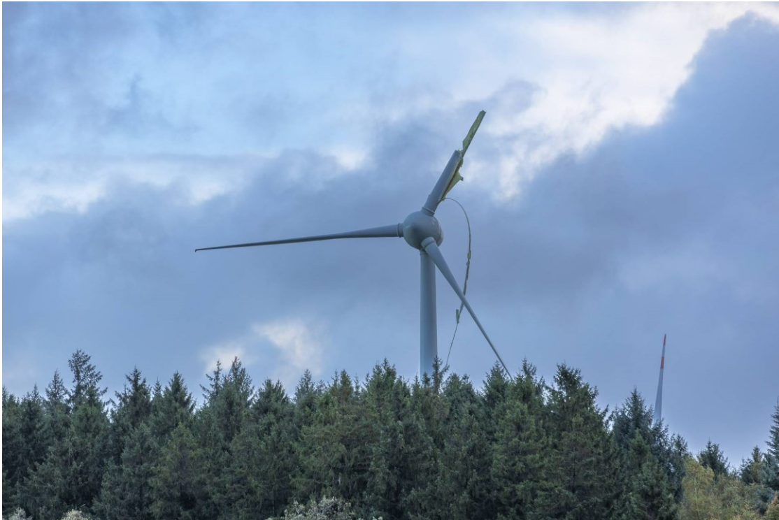
Abbildung 16: Abgeknicktes Rotorblatt, Aachener Zeitung, 2. November 2023, Foto Andreas Gabbert
