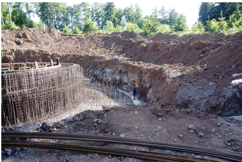
Abbildung 11: Fundamentbau Vogelsbergkreis Hessen, Foto Herrmann Dirr
